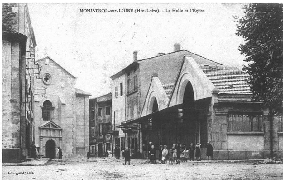
La nouvelle halle, et l'église avec sa nouvelle façade.
