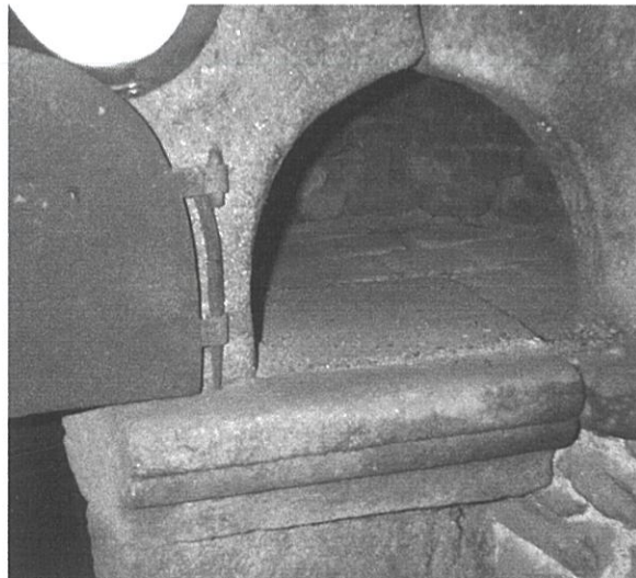
Four dans l'âtre dans une maison de Monistrol
