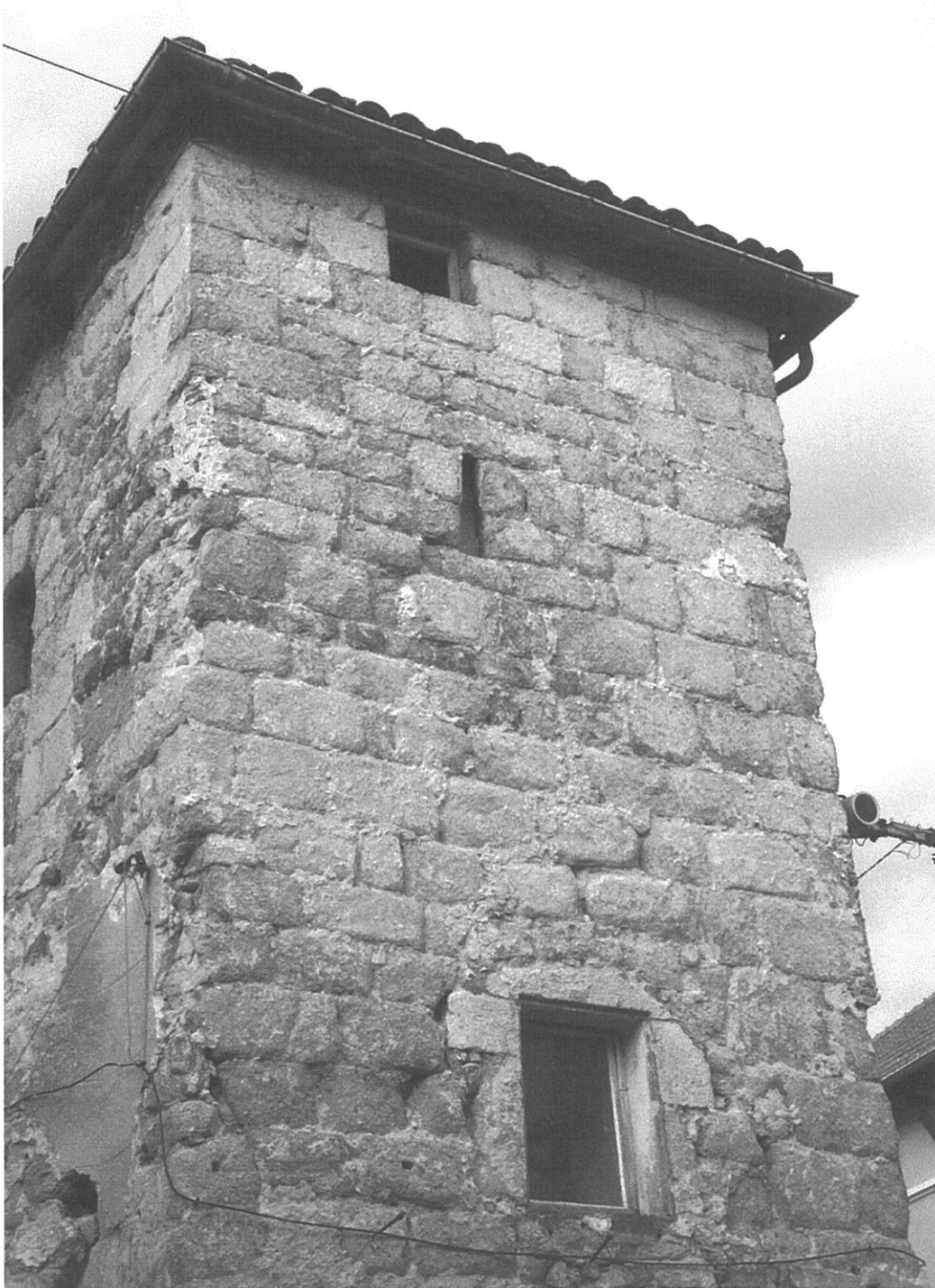
Derrière les enduits sont apparues de belles pierres d'appareil. La fenêtre a été percée ou élargie à l'époque moderne.
