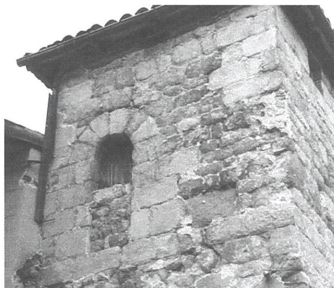
Une ouverture piétonne, en plein cintre, révélée par le décapage des enduits .
